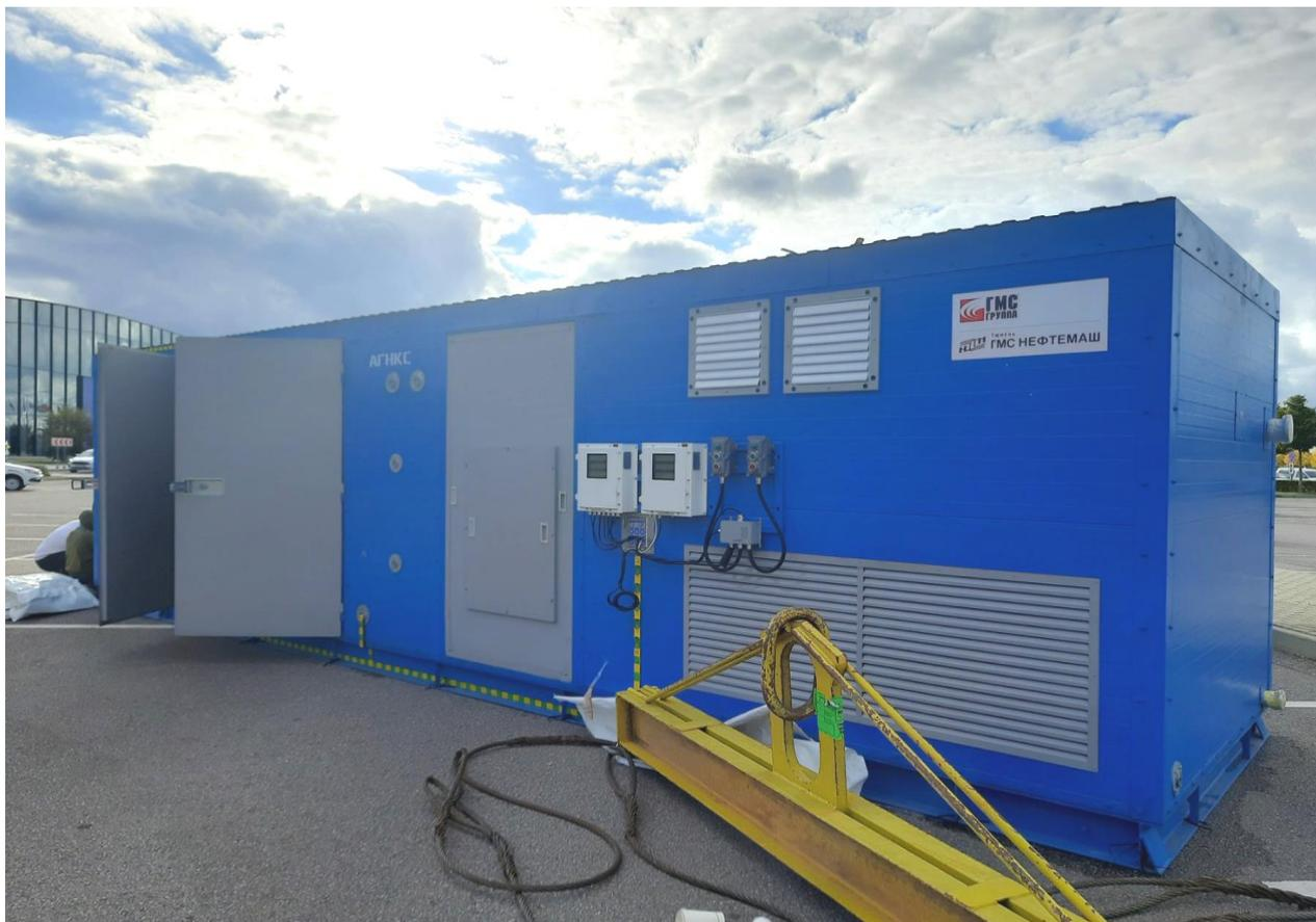
БКПГ выполнен в блочно-модульном исполнении полной заводской готовности и включает в себя:
